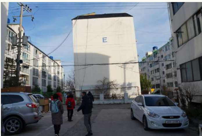
地震で傾いてしまったマンション ところどころコンクリートが崩れている
