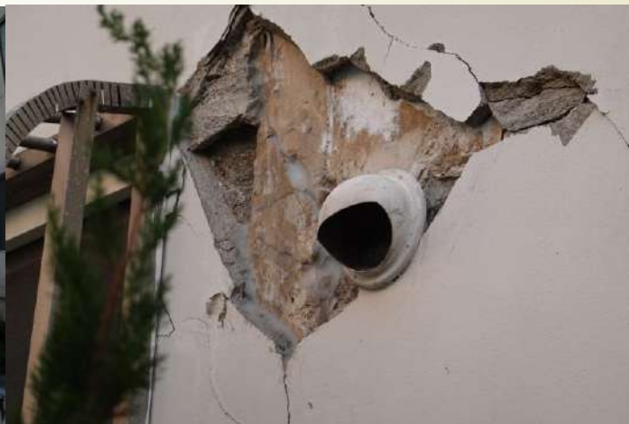
地震で傾いてしまったマンション ところどころコンクリートが崩れている
